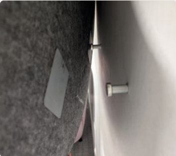
ENTRETOISES Kit entretoises de 30 ou 52 mm pour décaler 2 panneaux sur 3 du mur.
